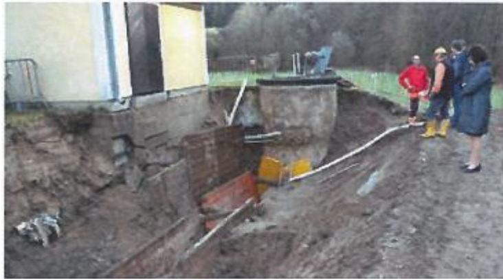
Grabungsarbeiten für die zu sanierende Filterstrecke bei der Brunnenanlage (erbaut um 1980) in Hohenstein
