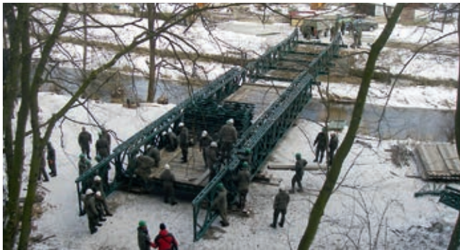
Bau – In 4 Tagen wurde die Ersatzbrücke errichtet.
