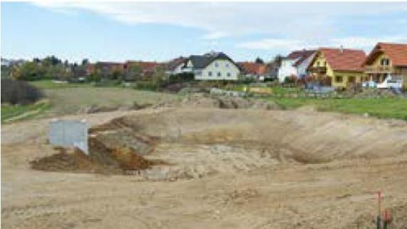
Das 1.760 m<sup>3</sup> große Rückhaltebecken dient zur Regenentwässerung des Betriebsgebietes und des Knotens Gföhl Ost.
